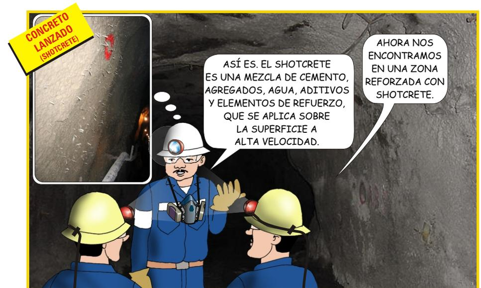
EL SHOTCRETE COMPRENDE LOS PROCESOS DE MEZCLA SECA Y DE MEZCLA HÚMEDA. TENER PRESENTE QUE LA PROPORCIÓN DE AGREGADOS DEBE SER LA ADECUADA PARA LOGRAR MAYOR ADHERENCIA. ADICIONALMENTE EL USO DE FIBRAS DE ACERO, LE DARÁ MAYOR RESISTENCIA.
