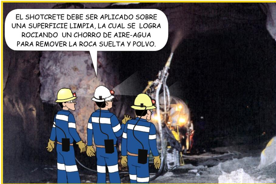
EL SHOTCRETE DEBE SER APLICADO SOBRE UNA SUPERFICIE LIMPIA, LA CUAL SE LOGRA ROCIANDO UN CHORRO DE AIRE-AGUA PARA REMOVER LA ROCA SUELTA Y POLVO.
